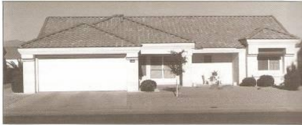
A. Luz frontal "apaga" a textura no telhado e na frente da casa.
