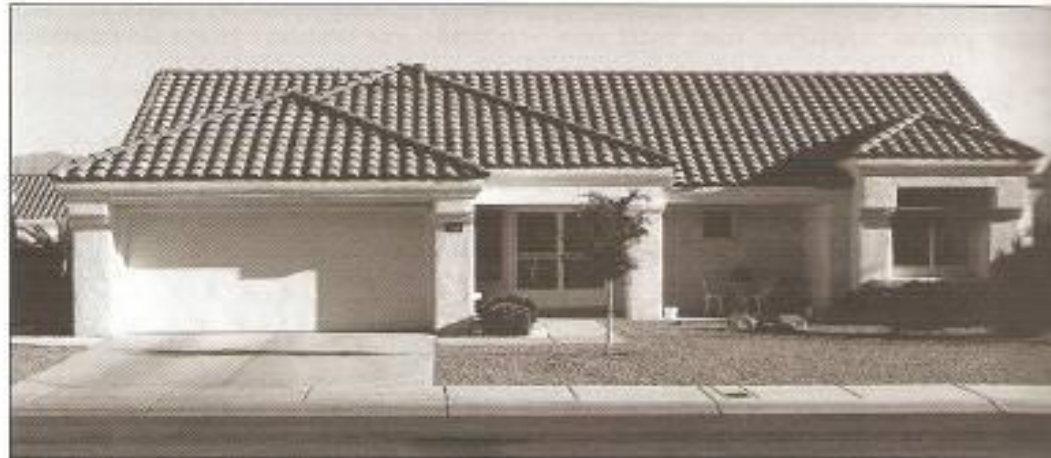
B. Luz lateral enfatiza as telhas e a pintura da casa.
